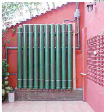
Modelo que armazena 320 litros de água da chuva, em casa na Lapa, na zona oeste de SP
