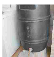
Modelo que armazena 320 litros de água da chuva, em casa na Lapa, na zona oeste de SP
